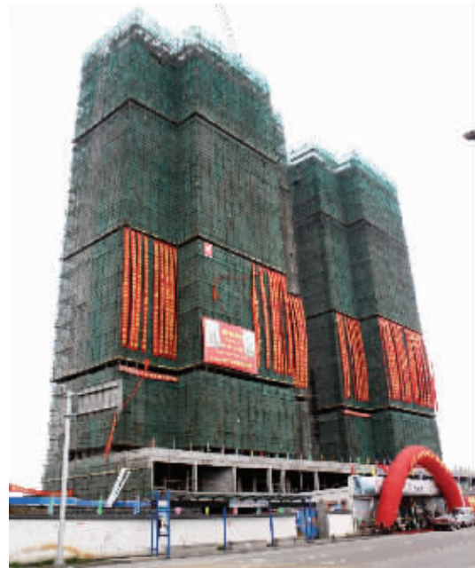
27层的兰亭国际公寓建设现场
