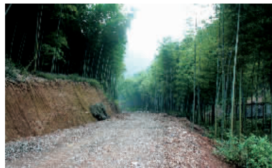
建设中的万亩竹笋基地作业道路
