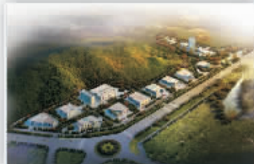
柯桥国际汽车城(在建)
